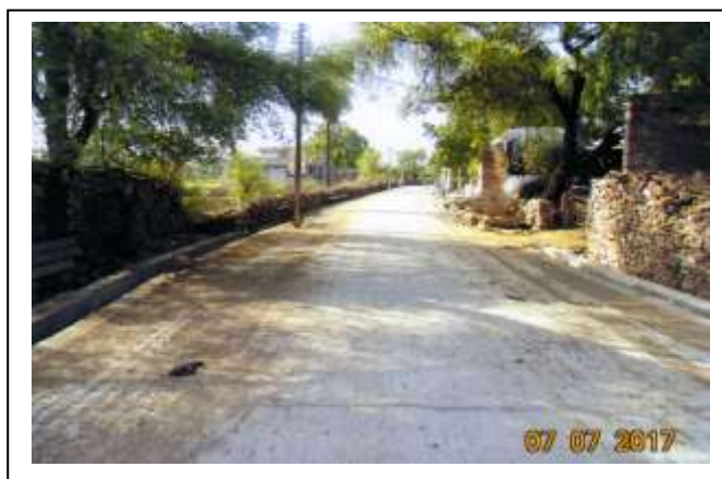
ग्राम जूनाखेडा में सड़क व नाली निर्माण का छायाचित्र
